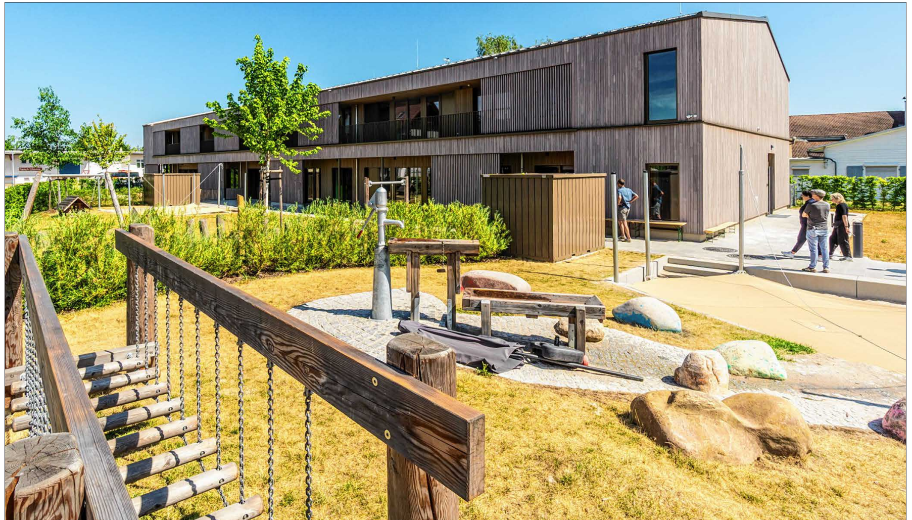
Die Kindertagesstätte Blumenau in Renchen erinnert mit ihrem langgestreckten Baukörper und dem flach geneigten Satteldach an eine Scheune. Nach Südwesten öffnet sich der Holzbau über eine Loggia zum abwechslungsreich gestalteten Spielgarten. Fotos: Ulrich Coenen
