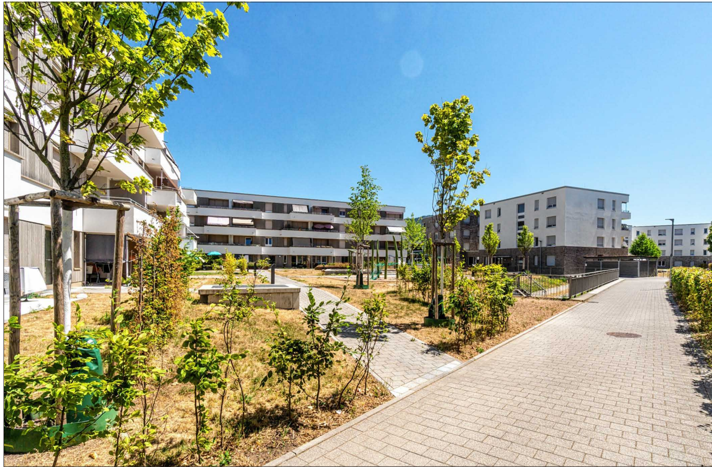
Im Zusammenspiel mit den Trakten des ersten Bauabschnitts ist im Seidenfaden ein großer und gärtnerisch gestalteter Innenhof mit hoher Aufenthaltsqualität entstanden.
