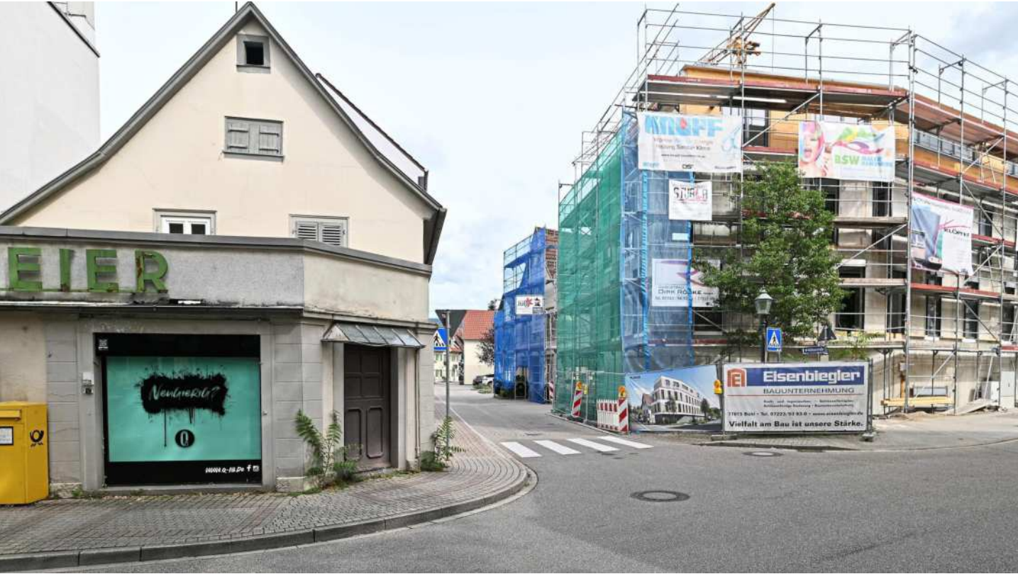
Große Baustelle: Das frühere Gasthaus König David wurde abgerissen und durch einen Neubau (rechts) ersetzt. Das Gasthaus Blume dahinter wird saniert. Das Schuhhaus Meier (links) ist vom Abriss bedroht.
